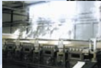
Afzuiginstallatie chloorbleekloogstraat Afzuigkap uit RVS 316 : 22 x 4 meter Afzuigcapaciteit : 72.500 m 3 /h
