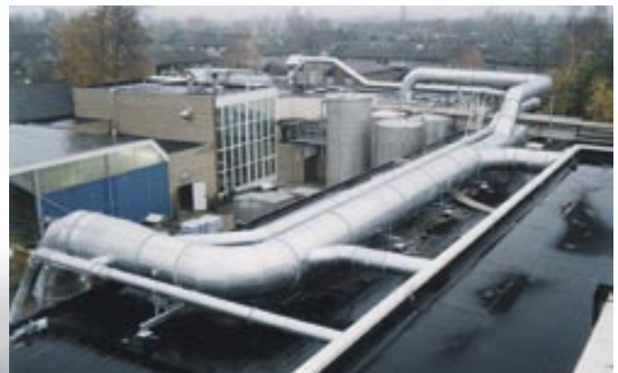
Geurafzuiginstallatie bij slachterij Capaciteit: 115.000 m 3 /h
