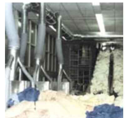
Zweefstofafzuiginstallatie bij wasserij
