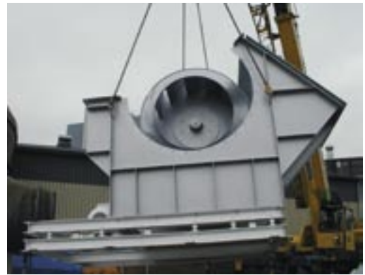
Montage rookgasventilator A 80 3/4 , capaciteit 250.000 m 3 /h
